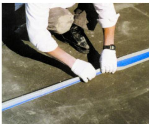
*Esempio di impermeabilizzazione di un giunto di dilatazione in un terrazzo*
