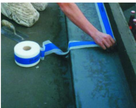
*Esempio di impermeabilizzazione di Mapeband dell'angolo tra fondo e parte di una vasca*
