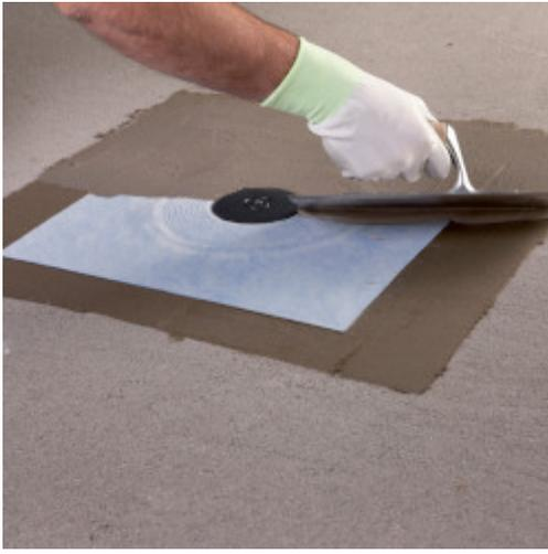
3. Misurare lo spessore necessario a collocare la griglia alla quota prevista, tenendo conto dello spessore dell'adesivo e delle piastrelle da impiegare
