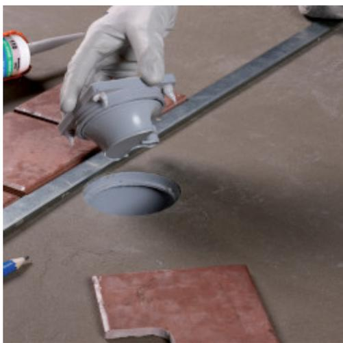
6. Dopo aver incollato la pavimentazione e stuccato le fughe, sigillare con Mapesil AC in corrispondenza della griglia di scarico a pavimento
