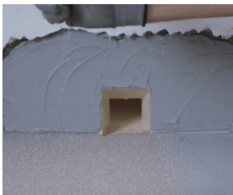
Impermeabilizzazione dello scarico con Drain Front
