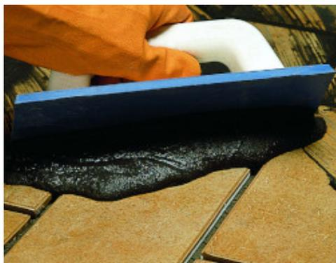
Stuccatura di pavimento esterno in klinker con **Keracolor GG** impastato con **Fugolastic**
